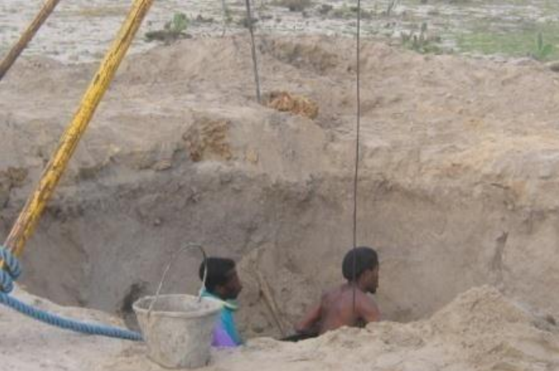
La mise en place des buses pour former le cuvelage du puits par les techniciens de Taratra.
